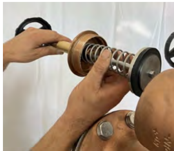
KFR-Ventileinsätze reinigen, ggf. austauschen
