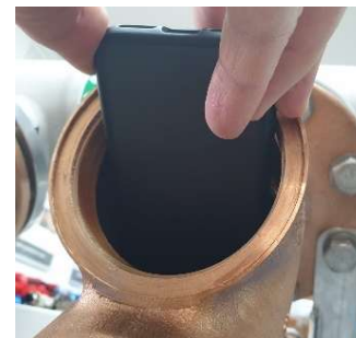
Kontrolle Einlaufrohr mittels Handykamera oder Endoskop, ggf. reinigen
