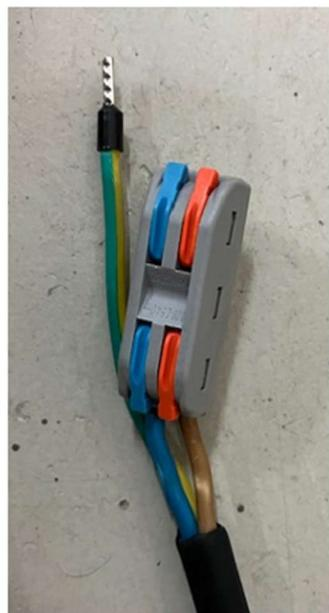
Kabelende Stromversorgung Kompressor
